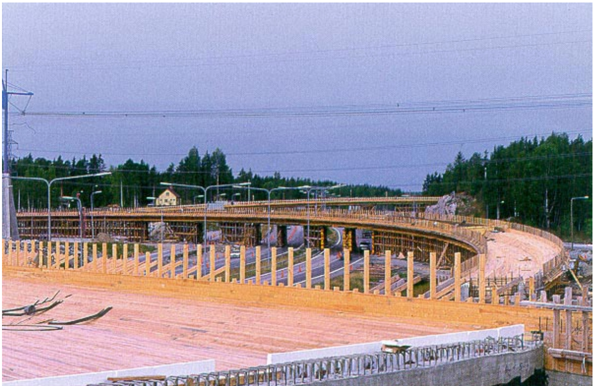
Kuva 1. Puuta käytössä. Turun-väylän liittymä rakenteilla Espoossa. Kuva Metla/Erkki Oksanen.
