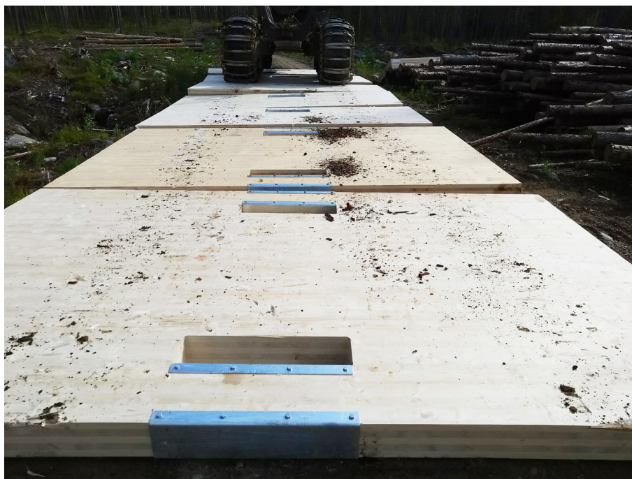
Kuva 1. Kantavuuden parantamiseen suunnitellut ja valmistetut CLT-levyt asennettuna ajouralle. Kerrosten määrä CLT-levyissä oli 4–7. Tartunta-aukot oli vahvistettu metallilla. Kuva: Anu Hilli / Suomen metsäkeskus.
